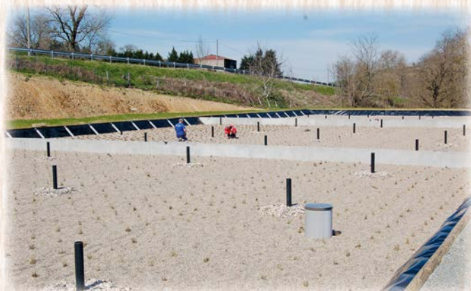
18 000 roseaux ont été plantés (à la main) sur les 2 étages de filtration.
