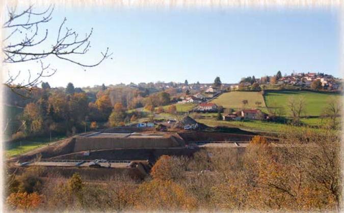
Malgré d'importants travaux de terrassement, l'ouvrage est bien inséré dans le site.
