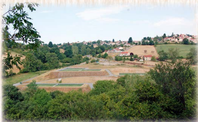
Opérationnel depuis le dernier trimestre 2015, ce nouvel équipement remplace la station de type « boues activées » en service depuis 1970.
