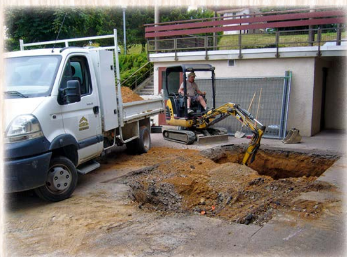
Une nouvelle cuve de fuel de 10 000 litres a été enterrée.
