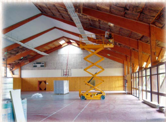
Les travaux d'isolation ont été privilégiés dans le cadre de cette opération de rénovation.
