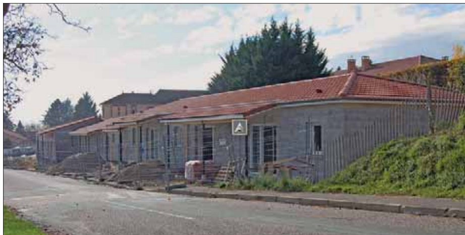
Pavillons en construction.
