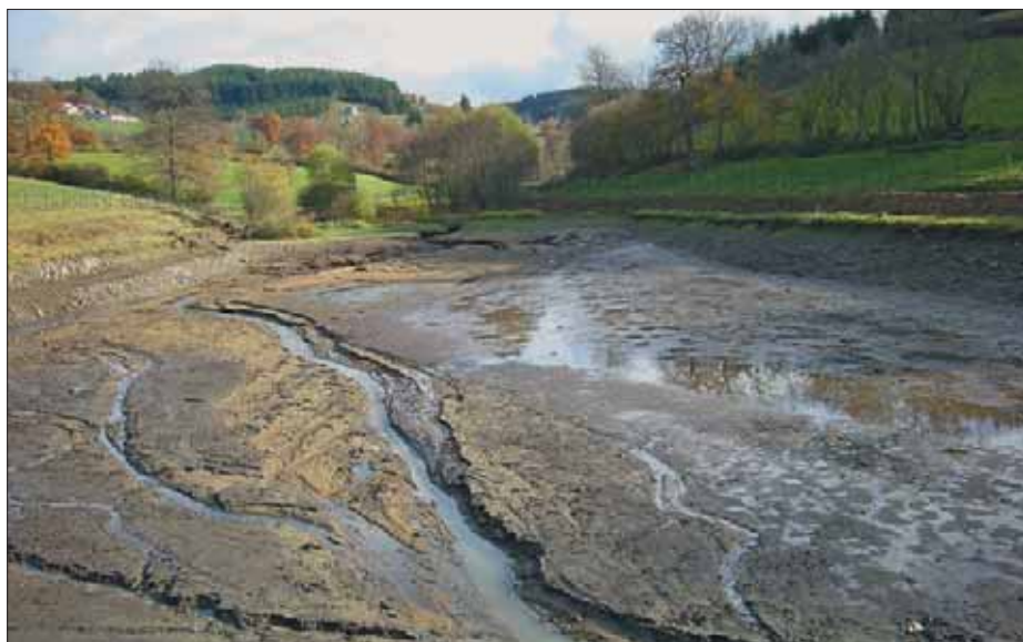
Le curage et la réfection de la digue.
