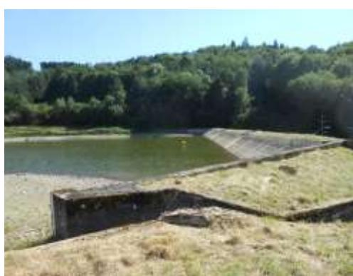
Cet ouvrage a fait l'objet de travaux en 2008-2009 notamment par un étanchement du masque amont de la rive gauche.
