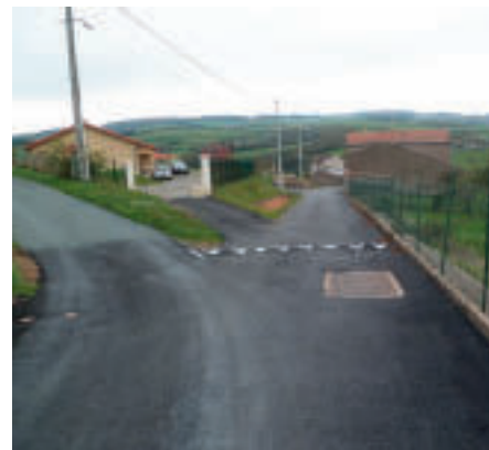
Réfection voirie rue de la Fontaine
